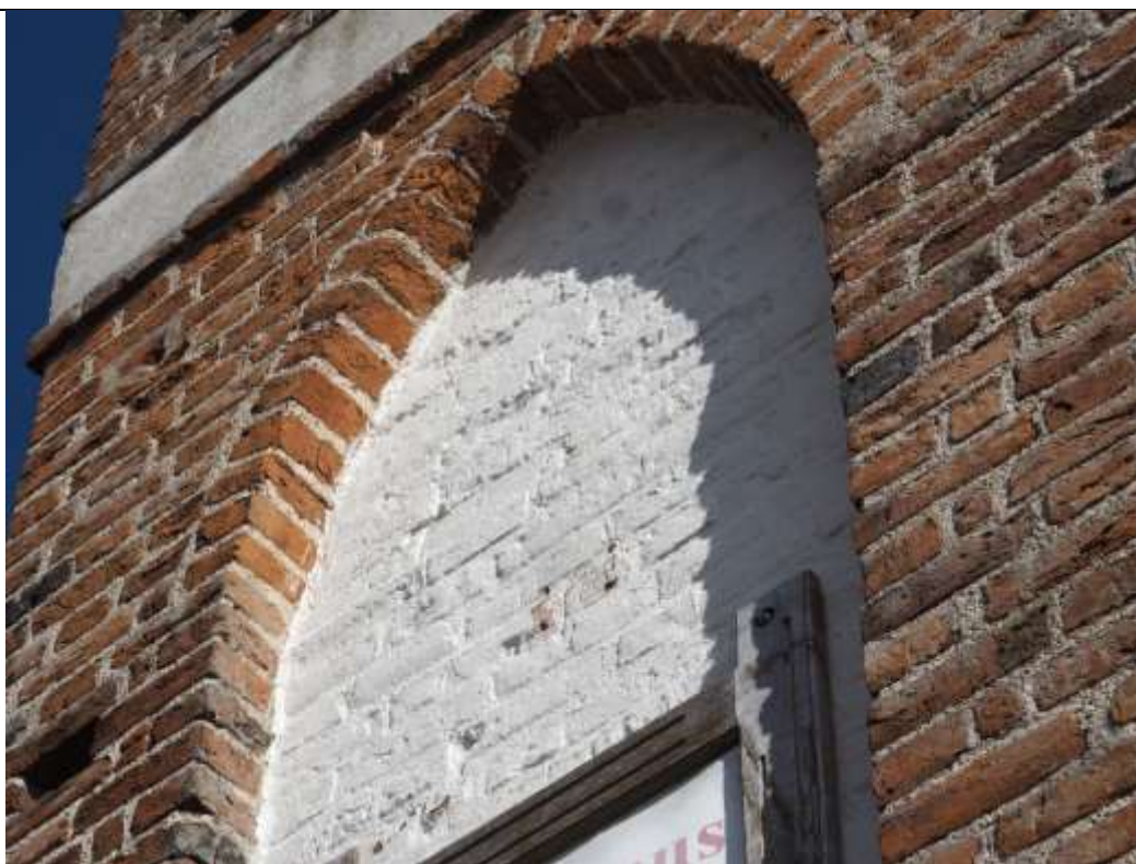
46. Galiny, kościół parafialny pw. Wniebowzięcia Najświętszej Maryi Panny; wieża, elewacja zachodnia, kondygnacja I, powyżej przyziemia, część północna – usunięty tynk we wnętrzu blendy; podłoże pokryte farbą.
