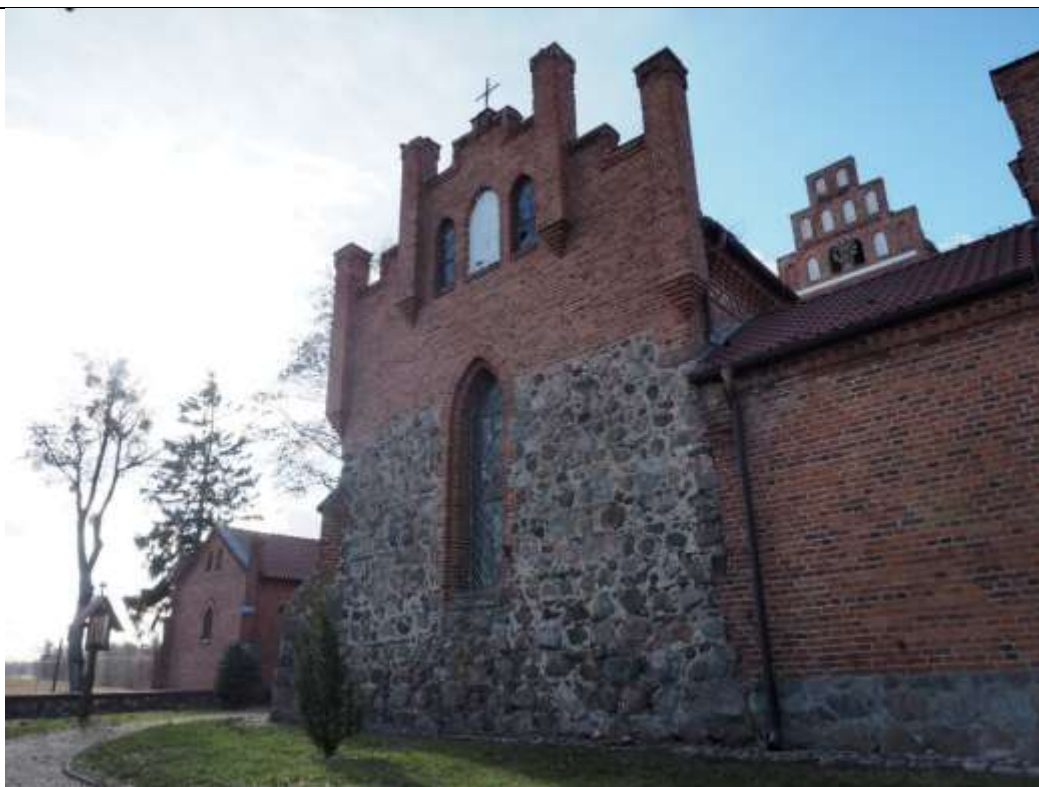
3. Galiny, kościół parafialny pw. Wniebowzięcia Najświętszej Maryi Panny; prezbiterium – widok ogólny, od strony północno-wschodniej.
