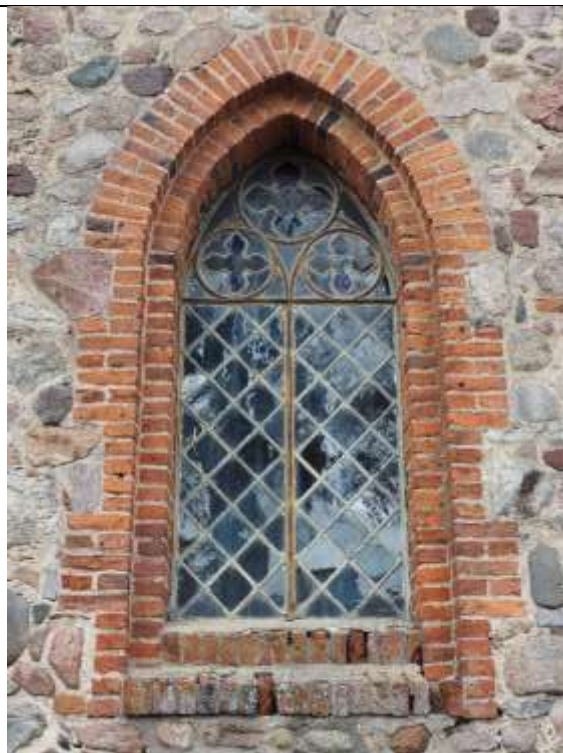
77. Galiny, kościół parafialny pw. Wniebowzięcia Najświętszej Maryi Panny; prezbiterium, elewacja południowa, część wschodnia; okno, strona zewnętrzna – widok ogólny.
