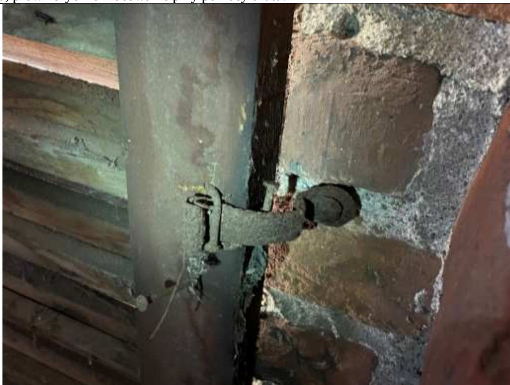
89. Galiny, kościół parafialny pw. Wniebowzięcia Najświętszej Maryi Panny; wieża, elewacja północna, kondygnacja III (IV), część wschodnia; okiennica, strona wewnętrzna – historyczne okucia mocujące, zaadoptowane za pomocą gwoździ drutu.
