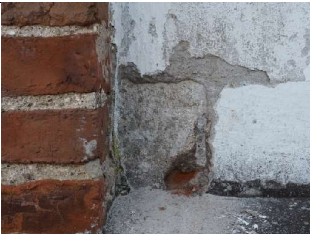
41. Galiny, kościół parafialny pw. Wniebowzięcia Najświętszej Maryi Panny; zakrystia, elewacja północna, kondygnacja I, część środkowa – wyprawy we wnętrzu blendy wykonane zaprawą cementową i cementowo-wapienną.
