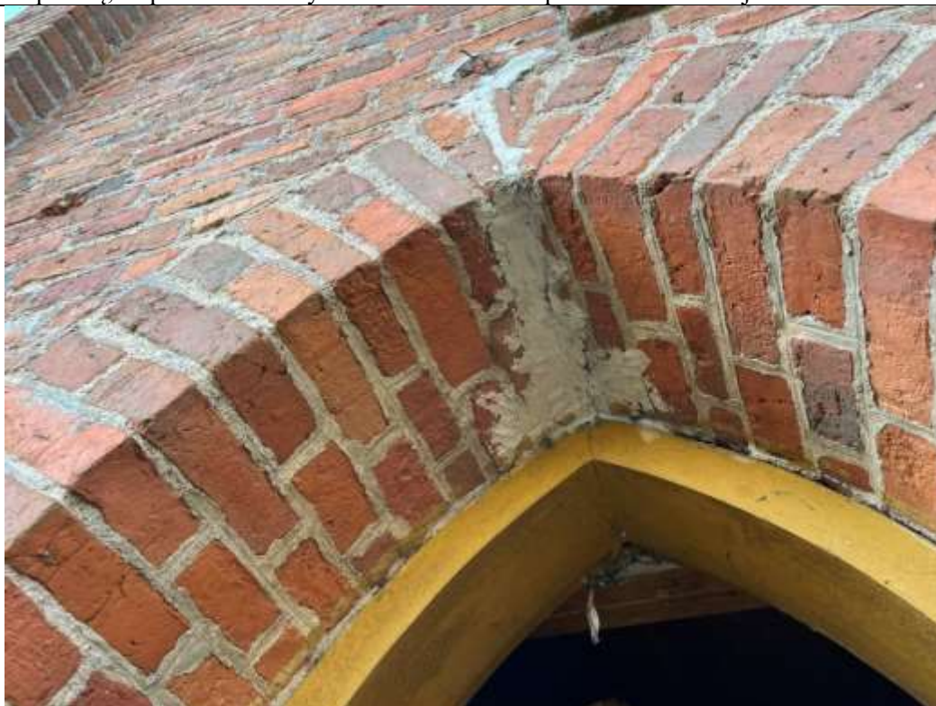
23. Galiny, kościół parafialny pw. Wniebowzięcia Najświętszej Maryi Panny; kruchta, elewacja północna, kondygnacja I, część wschodnia – wypełnienie bruzdy instalacyjnej w nadprożu otworu drzwiowego zaprawą cementową.
