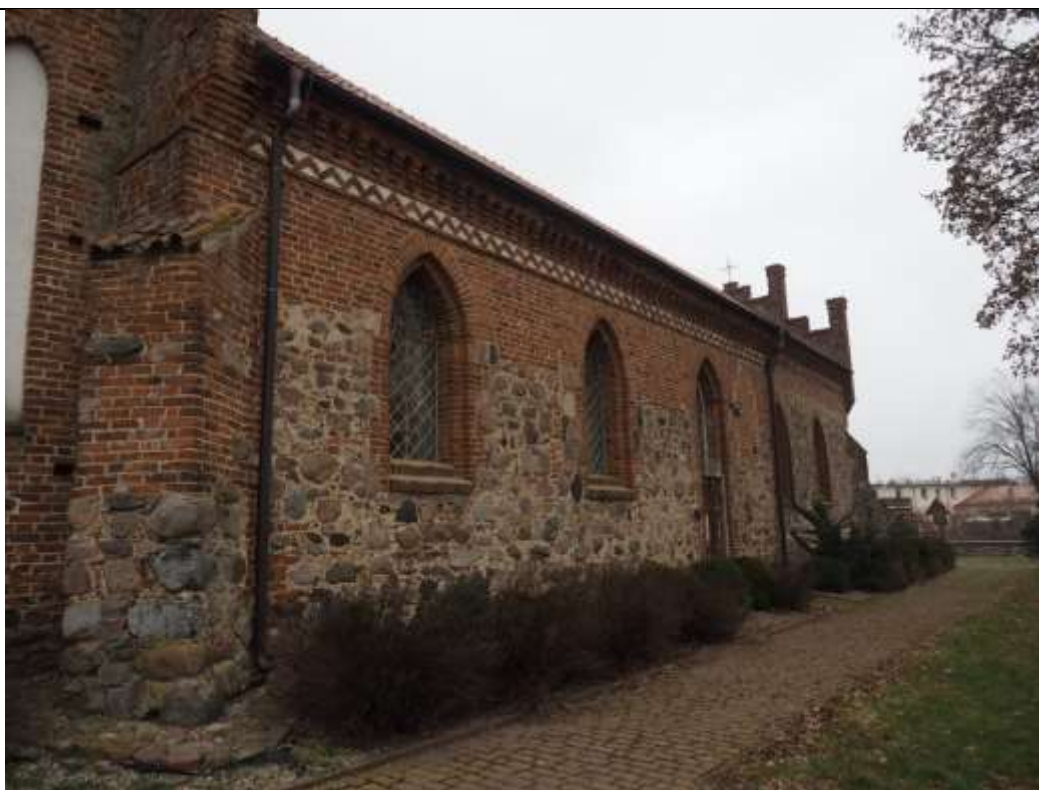
4. Galiny, kościół parafialny pw. Wniebowzięcia Najświętszej Maryi Panny; korpus i prezbiterium – widok ogólny, od strony południowo-zachodniej.
