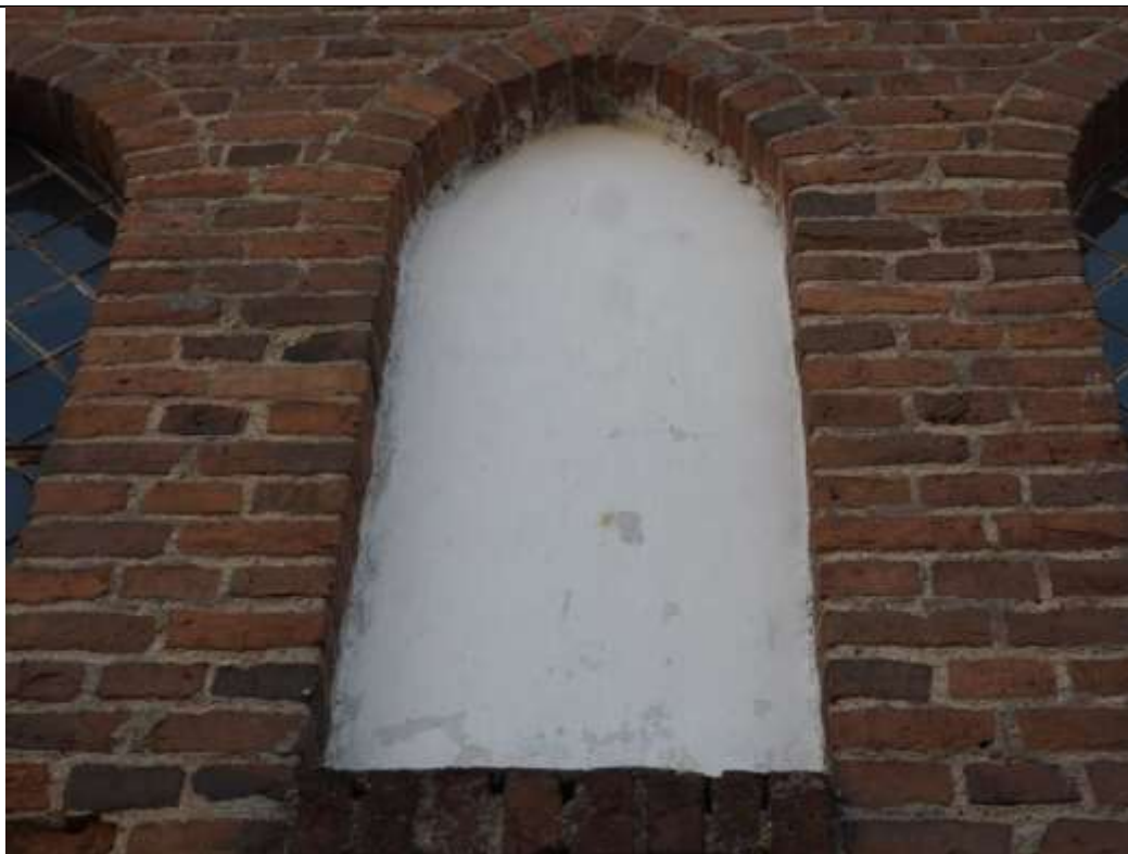
44. Galiny, kościół parafialny pw. Wniebowzięcia Najświętszej Maryi Panny; zakrystia, elewacja północna, kondygnacja II, część środkowa – powierzchnia tynku pokryta warstwami przemalowań.
