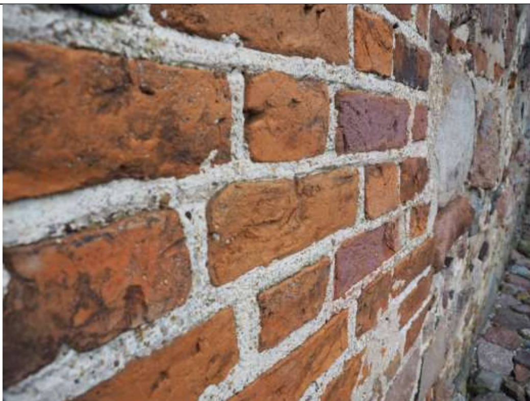
15. Galiny, kościół parafialny pw. Wniebowzięcia Najświętszej Maryi Panny; wieża, elewacja południowa, przyziemie, część zachodnia – pierwotne spoinowania wstęgu ceglano; czytelne opracowanie spoin.
