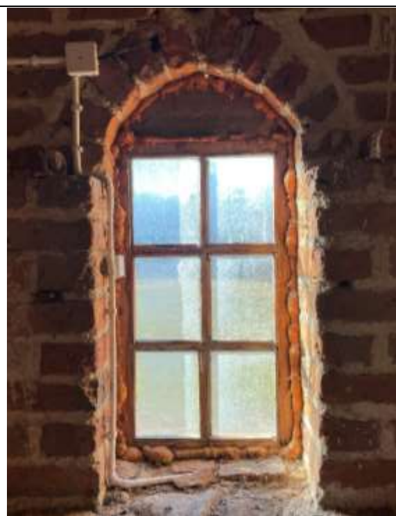
83. Galiny, kościół parafialny pw. Wniebowzięcia Najświętszej Maryi Panny; wieża, elewacja zachodnia, kondygnacja I (II); część środkowa; okno, strona wewnętrzna – widok ogólny.
