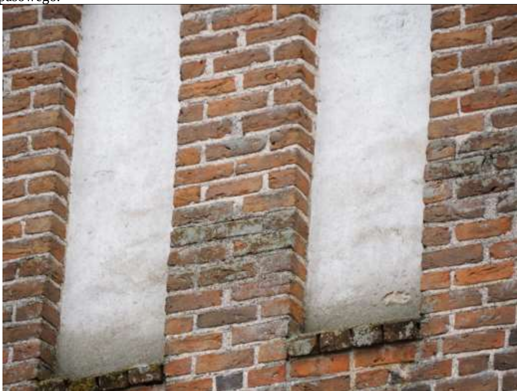
49. Galiny, kościół parafialny pw. Wniebowzięcia Najświętszej Maryi Panny; wieża, elewacja północna, kondygnacja II, część zachodnia – zawilgocenie, osłabienie strukturalne, ubytki wypraw w dolnych partiach blend.
