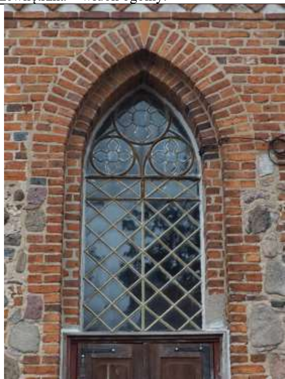
78. Galiny, kościół parafialny pw. Wniebowzięcia Najświętszej Maryi Panny; korpus, elewacja południowa, skraj wschodni; okno, strona zewnętrzna – widok ogólny.
