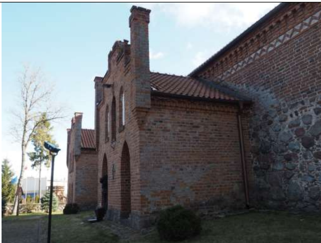
5. Galiny, kościół parafialny pw. Wniebowzięcia Najświętszej Maryi Panny; aneksy północne – widok ogólny, od strony północno-zachodniej.
