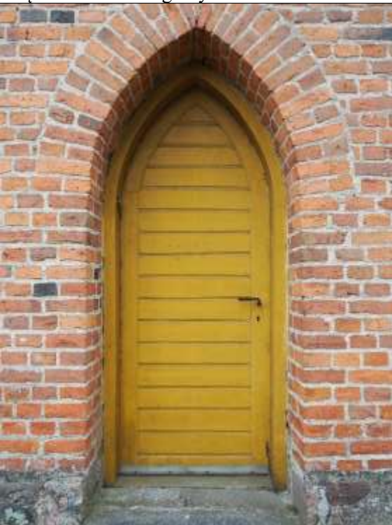
72. Galiny, kościół parafialny pw. Wniebowzięcia Najświętszej Maryi Panny; kruchta, elewacja północna, część zachodnia; drzwi, strona zewnętrzna – widok ogólny.
