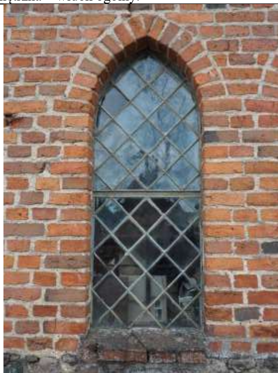
79. Galiny, kościół parafialny pw. Wniebowzięcia Najświętszej Maryi Panny; zakrystia, elewacja północna, kondygnacja I, część wschodnia; okno, strona zewnętrzna – widok ogólny.
