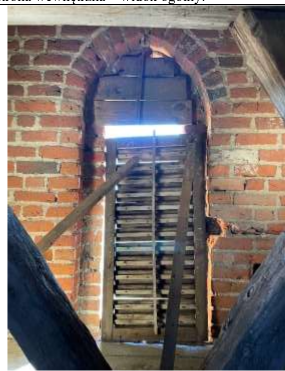
85. Galiny, kościół parafialny pw. Wniebowzięcia Najświętszej Maryi Panny; wieża, elewacja północna, kondygnacja III (IV), część zachodnia; okiennica, strona wewnętrzna – widok ogólny.
