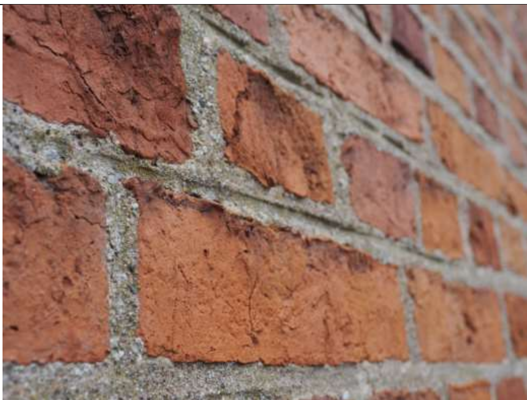
20. Galiny, kościół parafialny pw. Wniebowzięcia Najświętszej Maryi Panny; zakrystia, elewacja zachodnia, przyziemie, część północna – lico XIX- wiecznego wątku ceglanego; czytelne opracowanie spoin.
