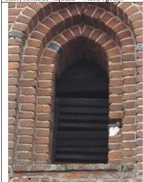
84. Galiny, kościół parafialny pw. Wniebowzięcia Najświętszej Maryi Panny; wieża, elewacja północna, kondygnacja III (IV), część zachodnia; okiennica, strona zewnętrzna – widok ogólny
