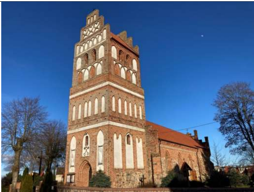
2. Galiny, kościół parafialny pw. Wniebowzięcia Najświętszej Maryi Panny – widok ogólny, od strony południowo-zachodniej.
