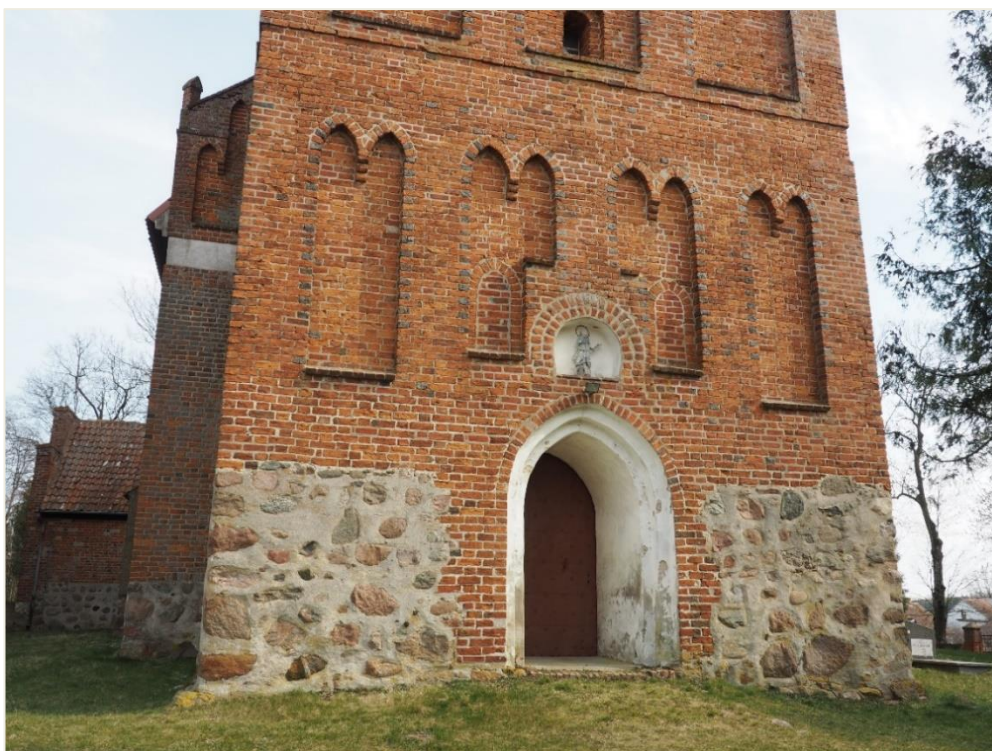
7. Wozławki, kościół parafialny p.w. Św. Antoniego Opata; wieża - elewacja zachodnia, przyziemie; widok od strony północno – zachodniej.
