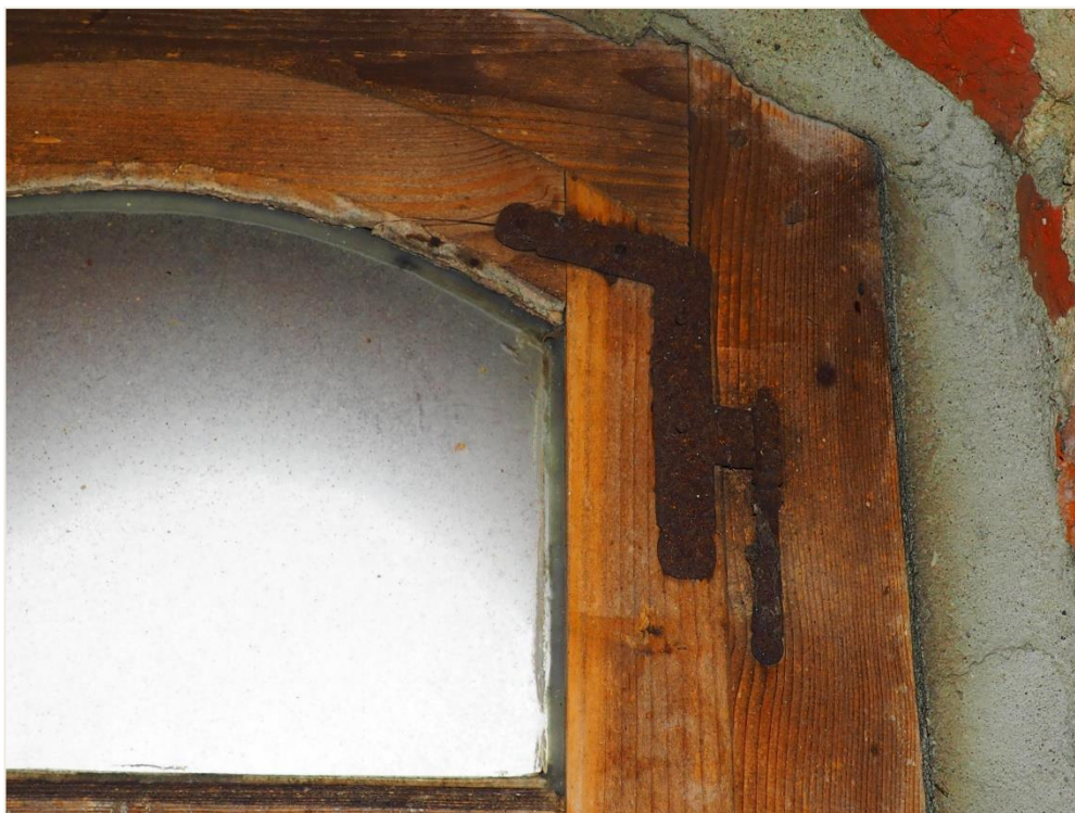
64. Wozławki, kościół parafialny p.w. Św. Antoniego Opata; wieża, elewacja zachodnia, kondygnacja II – okno, rewers (wnętrze piętra I). Przykład i stan zachowania okuć łączących (zawias górny).
