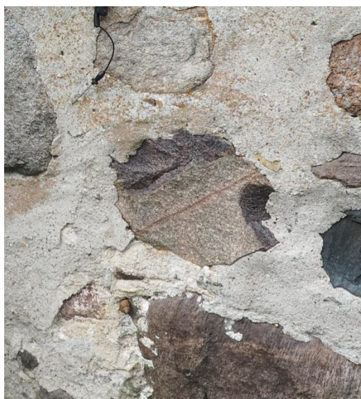
Przykłady cementowej zaprawy na licu muru kamiennego. Zaprawa została użyta do wypełnienia ubytków i uzupełnienia lica zaprawy murarskiej między głazami.
