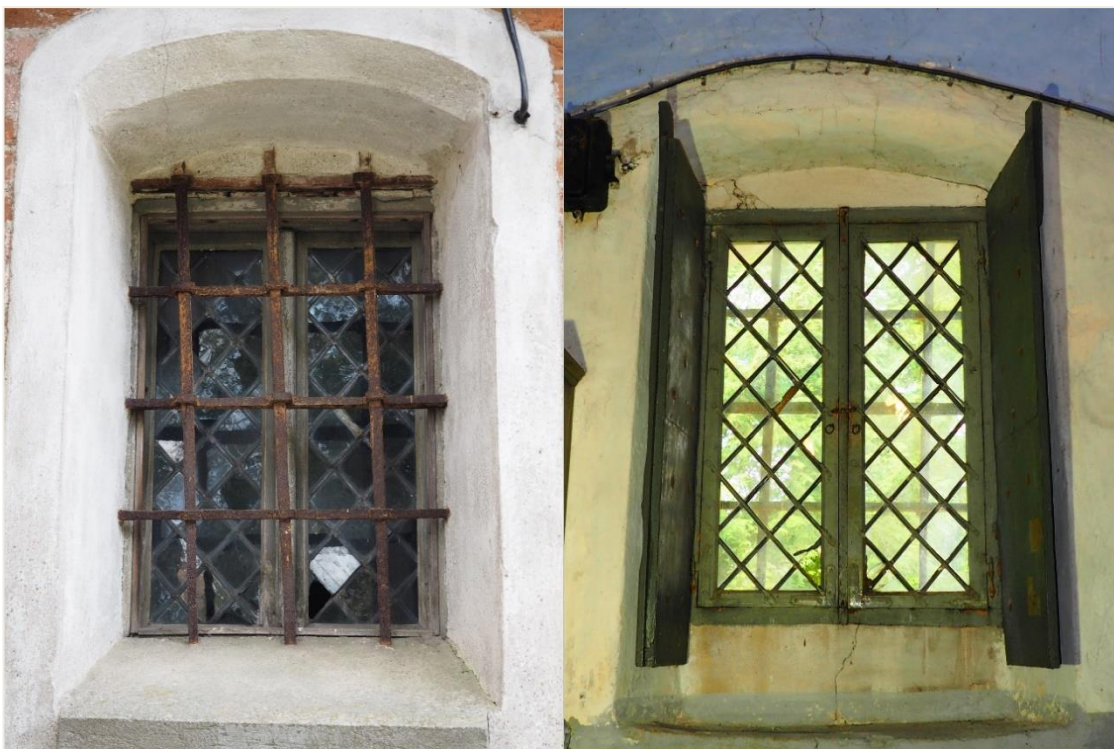
44. Wozławki, kościół parafialny p.w. Św. Antoniego Opata; zakrystia - elewacja wschodnia (przyziemie); okno, strona zewnętrzna, z kratą i strona wewnętrzna, z okiennicami.
