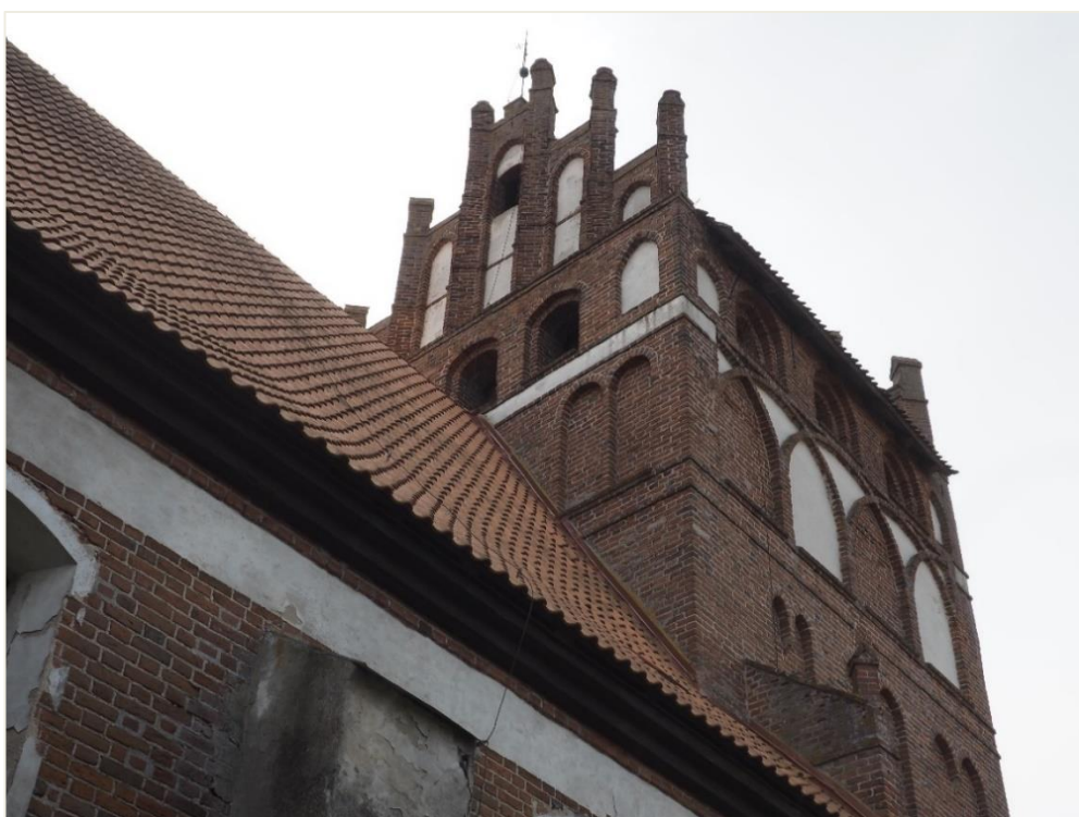
8. Wozławki, kościół parafialny p.w. Św. Antoniego Opata; wieża - elewacje wschodnia i północna (kondygnacje III-IV); widok od strony północno – wschodniej.
