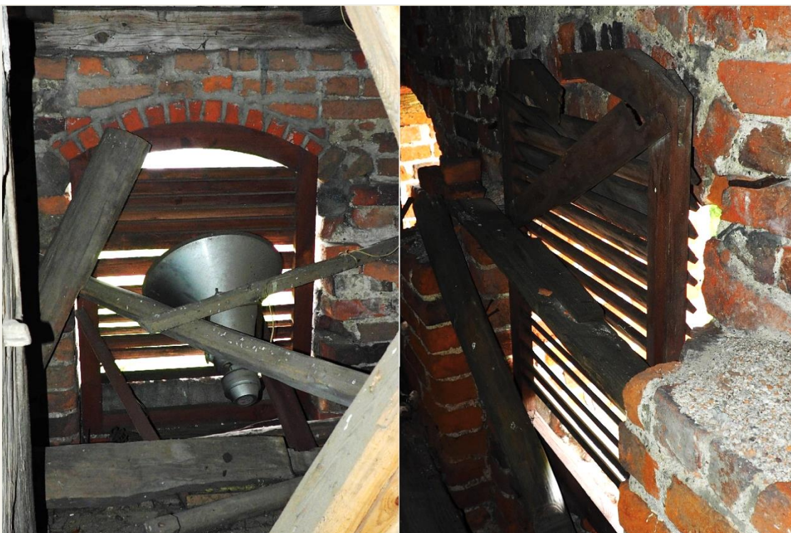
48. Wozławki, kościół parafialny p.w. Św. Antoniego Opata; wieża - elewacja północna, kondygnacja IV (wnętrze, piętro V - dzwonnica); współczesne okiennice żaluzjowe, strona wewnętrzna.
