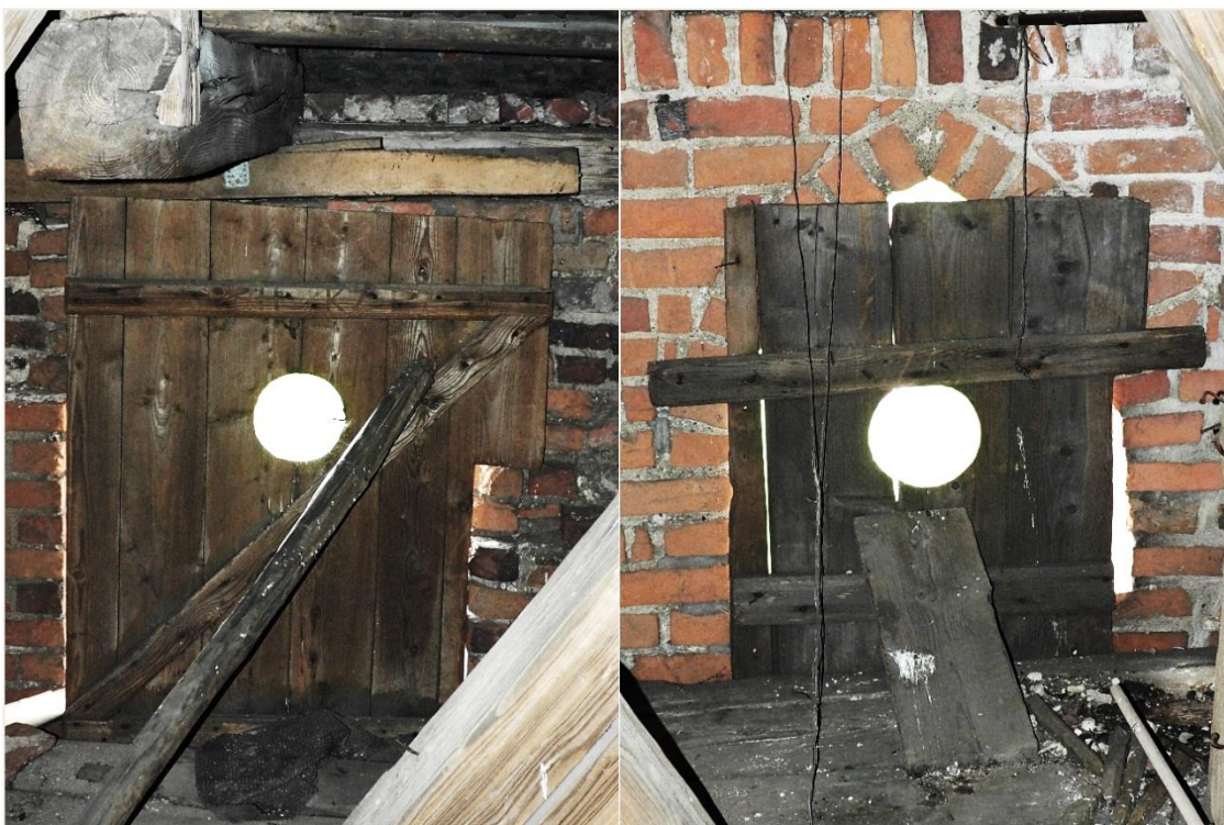
47. Wozławki, kościół parafialny p.w. Św. Antoniego Opata; wieża - elewacja północna, kondygnacja IV (wnętrze, piętro V - dzwonnica); okiennice, deskowo – szpungowe, strona wewnętrzna.
