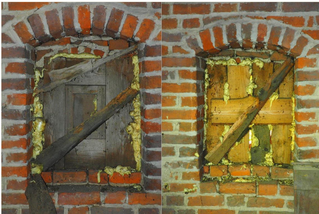
43. Wozławki, kościół parafialny p.w. Św. Antoniego Opata; korpus - elewacja wschodnia, szczyt (poziom I, strony, północna i południowa); okno, strona wewnętrzna i prowizoryczne zaślepienie przeźrocza.
