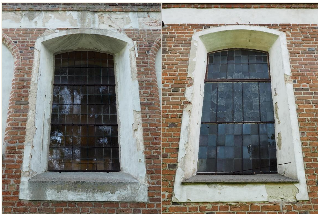
41. Wozławki, kościół parafialny p.w. Św. Antoniego Opata; korpus - elewacje, wschodnia i północna; okna, strona zewnętrzna; wariant pierwszy, uproszczony i wariant drugi, z przedstawieniem figuralnym (lub motywem ornamentacyjnym).
