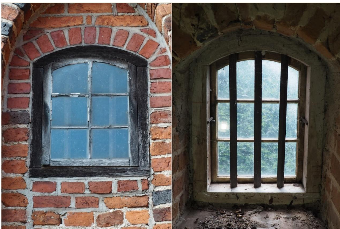
45. Wozławki, kościół parafialny p.w. Św. Antoniego Opata; wieża - elewacja południowa, kondygnacja I, skraj wschodni (wnętrze, piętra 0-I); okno, strona zewnętrzna i strona wewnętrzna, z kratą.
