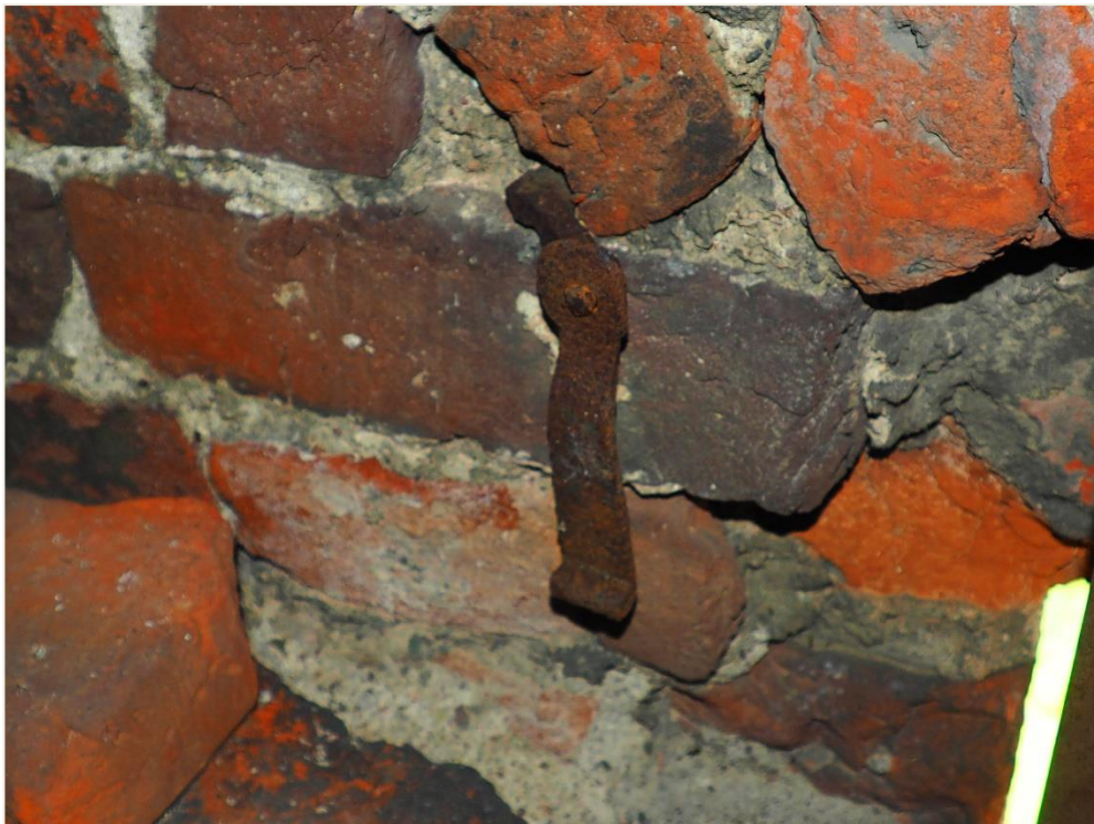
70. Wozławki, kościół parafialny p.w. Św. Antoniego Opata; wieża, elewacja północna, kondygnacja IV – okiennica deskowo – szpungowa, rewers (wnętrze, piętro V - dzwonnica). Przykład i stan zachowania okuć zamykających (zakrętka dźwigniowa).
