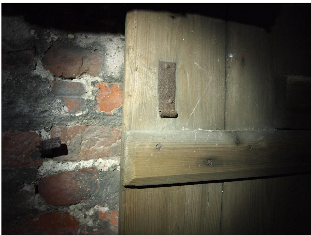
71. Wozławki, kościół parafialny p.w. Św. Antoniego Opata; wieża, elewacja północna, kondygnacja IV – okiennica deskowo – szpungowa, rewers (wnętrze, piętro V - dzwonnica). Przykład i stan zachowania okuć zamykających (docisk zakrętki dźwigniowej).
