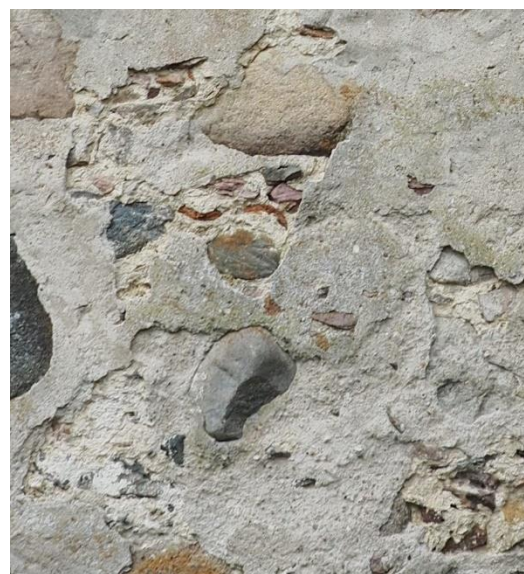
Przykłady cementowej zaprawy na licu muru kamiennego. Zaprawa została użyta do wypełnienia ubytków i uzupełnienia lica zaprawy murarskiej między głazami.
