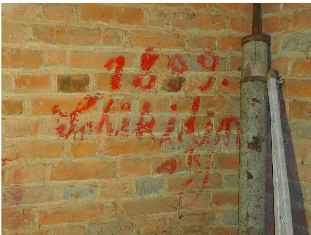
75. Wozławki, kościół parafialny p.w. Św. Antoniego Opata; wieża (wnętrze, piętro I). Pamiątkowa sygnatura z datą „1889”, odnosząca się do prac remontowych.
