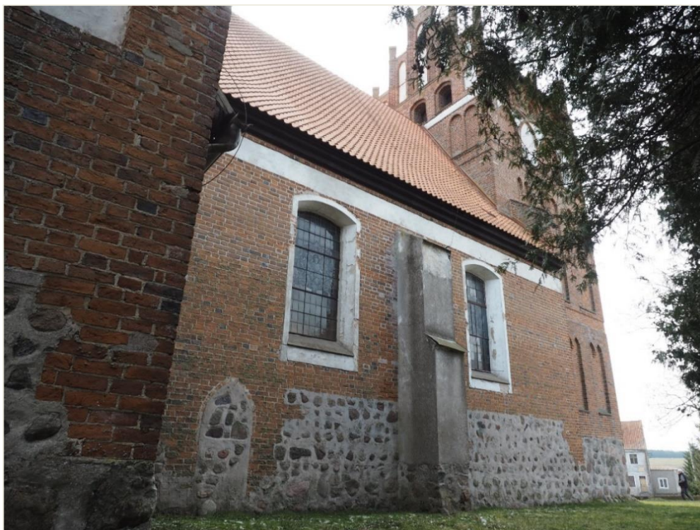
5. Wozławki, kościół parafialny p.w. Św. Antoniego Opata; korpus - elewacja północna, część środkowa i zachodnia; widok od strony północno – wschodniej.
