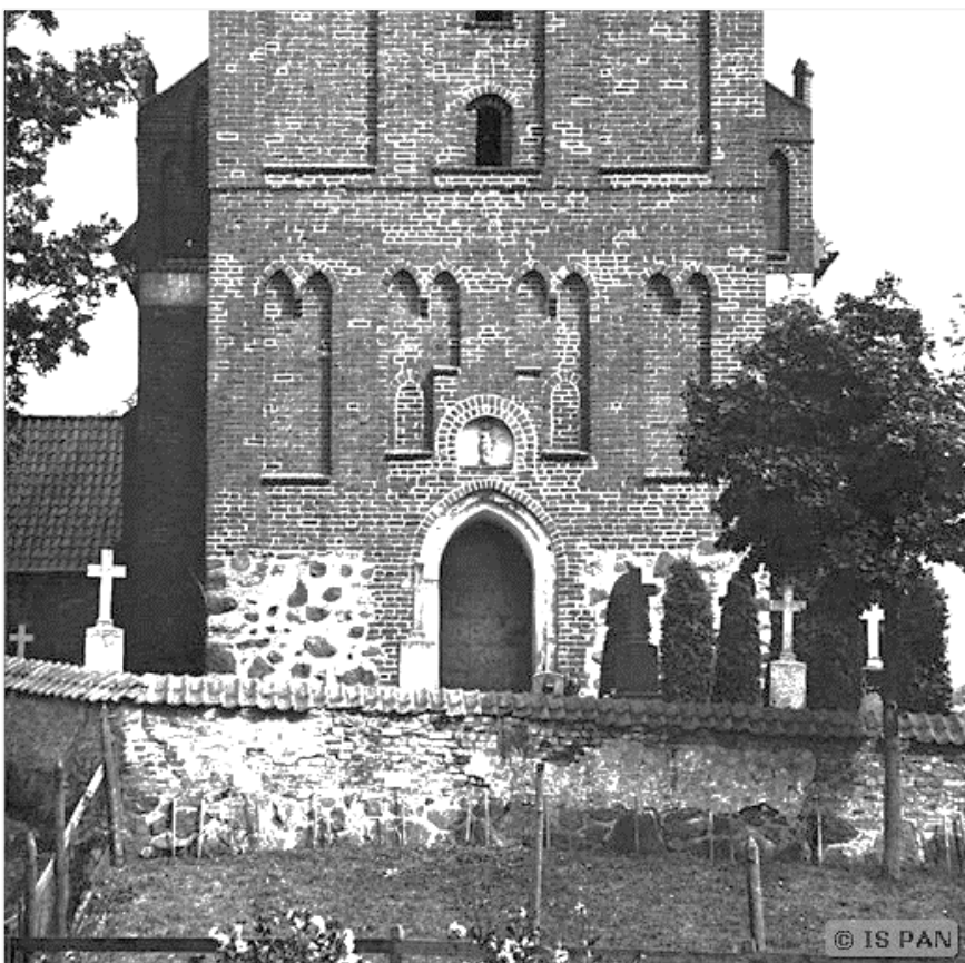
7. Wozławki – kościół parafialny, wieża (1938); elewacja zachodnia, kondygnacje I-II, widok od strony zachodniej (aut. nn.), [za:] J. Przykowski (red.), Prusy wschodnie – dokumentacja historycznej prowincji. Zbiory fotograficzne dawnego Urzędu Konserwatora Zabytków w Królewcu , Warszawa 2006 [CD-rom], IS PAN/ ZFiRP, nr. in. 59165.
