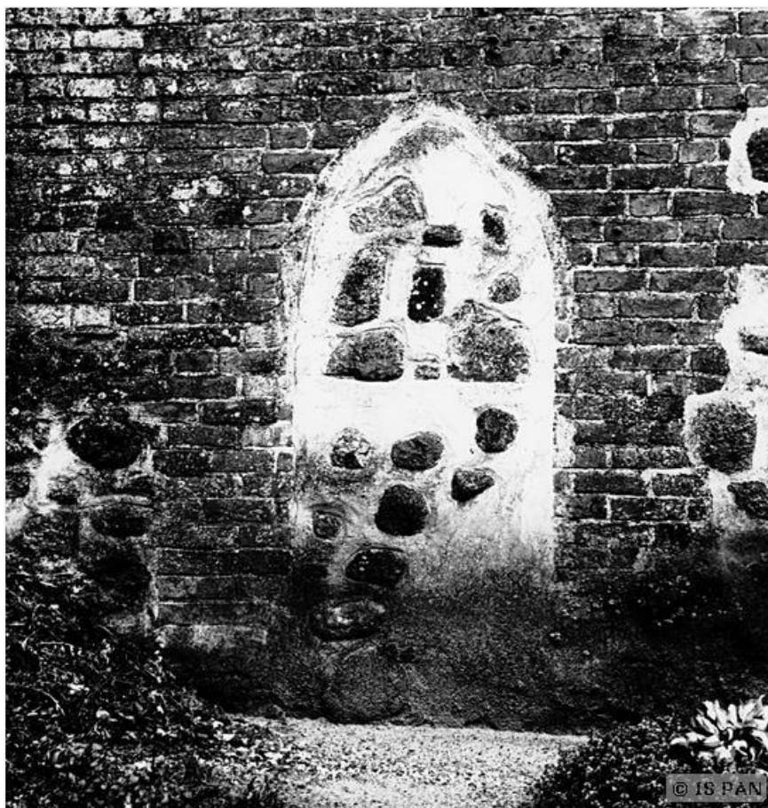
5. Wozławki – kościół parafialny, fragment elewacji południowej korpusu (1938); przyziemie, zamurowany portal (aut. nn.), [za:] J. Przytkowski (red.), Prusy wschodnie – dokumentacja historycznej prowincji. Zbiory fotograficzne dawnego Urzędu Konserwatora Zabytków w Królewcu , Warszawa 2006 [CD-rom], IS PAN/ ZFiRP, nr. in. 59168.
