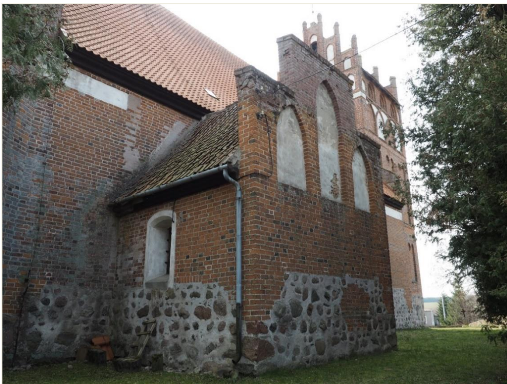
3. Wozławki, kościół parafialny p.w. Św. Antoniego Opata; zakrystia - elewacje wschodnia i północna; widok od strony północno – wschodniej
