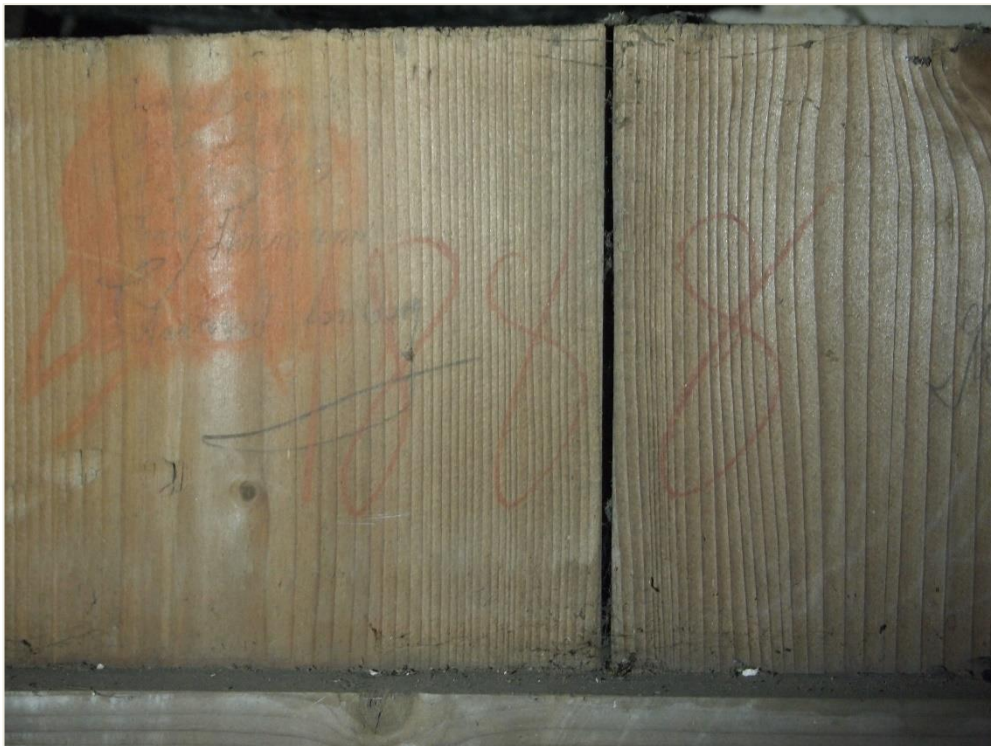
72. Wozławki, kościół parafialny p.w. Św. Antoniego Opata; wieża, elewacja północna, kondygnacja IV – okienca deskowo – szpungowa, rewers (wnętrze, piętro V - dzwonnica). Pamiątkowa sygnatura z datą „1888”, odnosząca się do prac remontowych i wymiany stolarek elewacyjnych.
