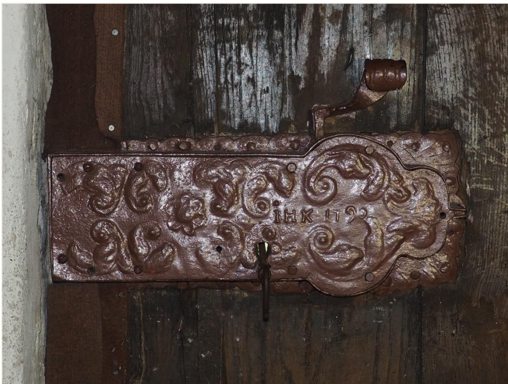
51. Wozławki, kościół parafialny p.w. Św. Antoniego Opata; wieża – drzwi; rewers (wnętrze kruchty wieżowej). Przykład i stan zachowania historycznych okuć zamykających (zamek skrzynkowy ze zintegrowaną klamką; ubytki elementów łączących ostony przedniej).
