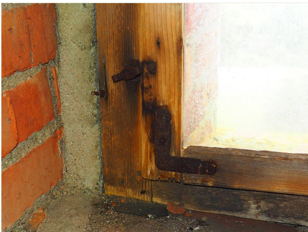
67. Wozławki, kościół parafialny p.w. Św. Antoniego Opata; wieża, elewacja zachodnia, kondygnacja II – okno, rewers (wnętrze piętra I). Przykład i stan zachowania historycznych okuć łączących oraz zamykających (dolne, narożnik i zakrętka; brak docisku).
