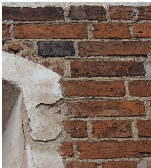
Przykład historycznego opracowania średniowiecznych spoin zachowanych na licu elewacji.
